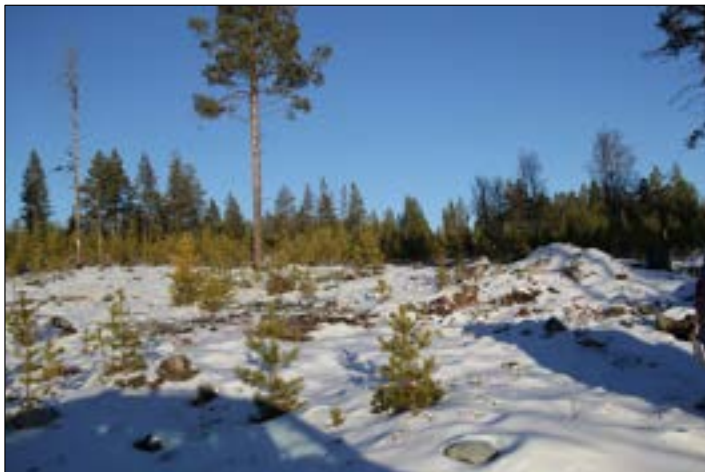
Figur 5. Resten av vegen og kabelgrøft bygges gjennom tørr skogsmark
